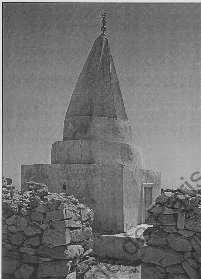
Figure 176 : Mausolée de Cheikh Barakât, vue générale vers le sud-ouest.
