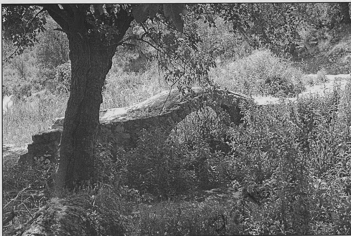
Figure 209 : Pont de Pira Silat, Lalış, vue vers le nord-est.
