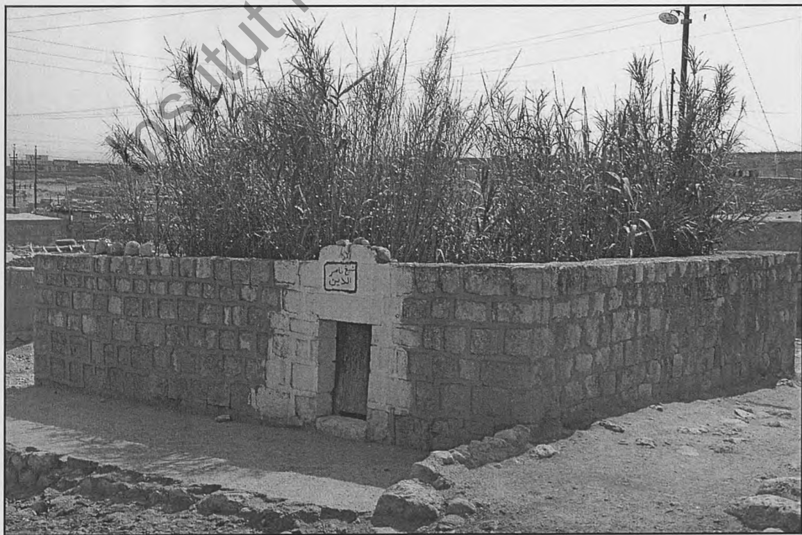
Figure 86 : Mausolée de Cheikh Nasr al-Dîn, Bozan, vue vers le sud-ouest.
