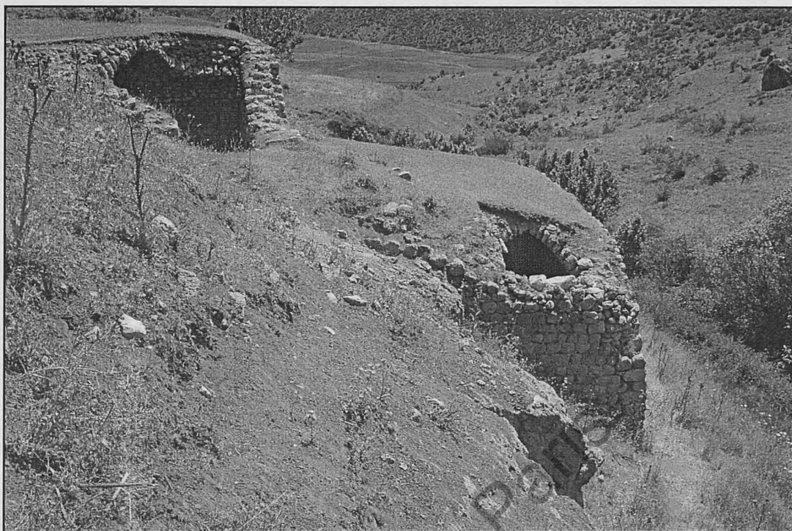
Figure 207 : Caravansérail de Xana Êzî, le logement et la chambre mitoyenne adossés au terrain, vue vers le nord.
