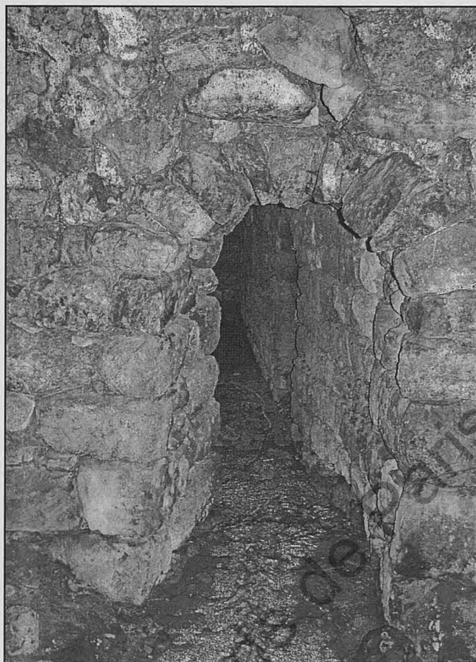
Figure 57 : Sanctuaire de Cheikh 'Adî, Çîlexanê, passage permettant l'accès au quatrième espace, vue vers l'est.
