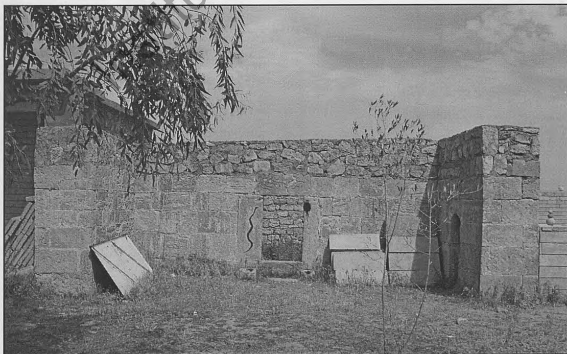
Figure 134 : Mausolée de Cheikh Abû Bekir, Mem Şivan, vue vers le sud.
