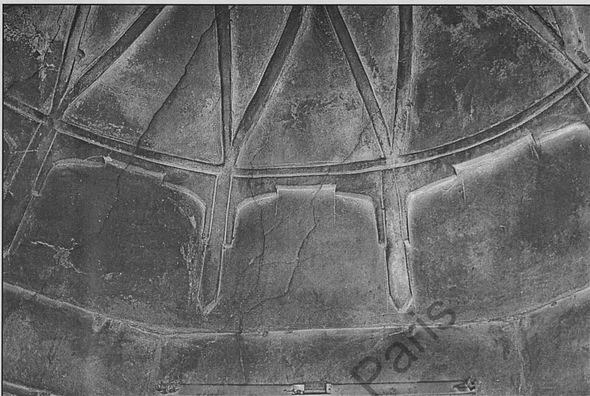
Figure 77 : Mausolée de Cheikh Suwar, niches décoratives en anse panier sur la face interne du dôme.
