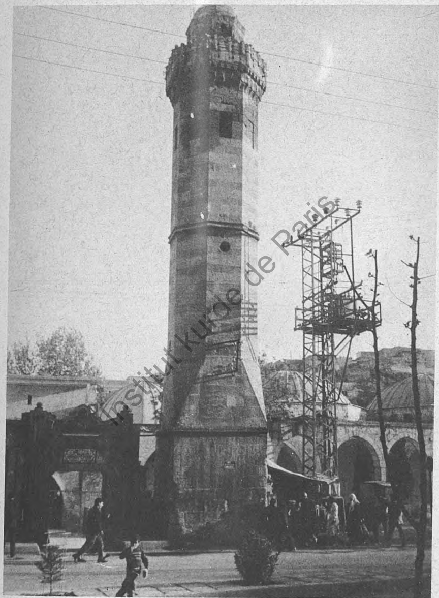
Hasan Paşa Camii minaresi.
