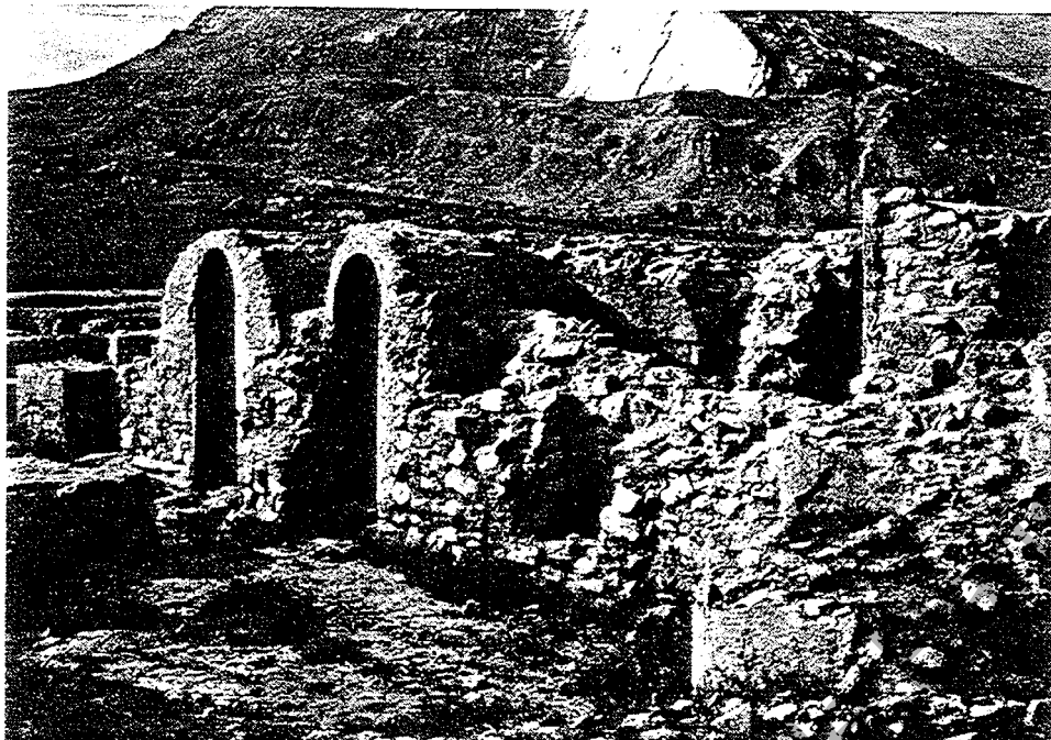
Temple ou Eglise de Bazyan facade sud
