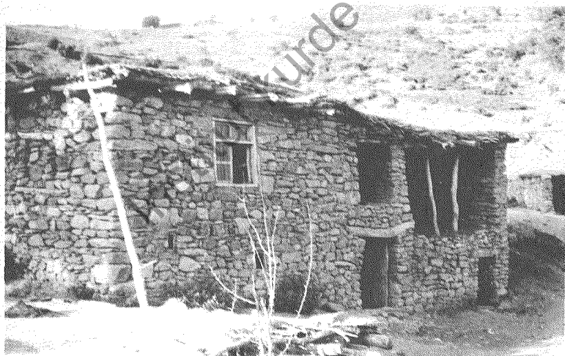
Abb. 18 Das typische Haus des Kettentaurus ist zweistöckig und mit der Rückseite in den Hang hineingebaut. Die Wohnräume haben größere Fenster. Der nach vorne offene Teil des Obergeschosses dient als Speicher für Heu und Stroh (Çuh, Kreis Çatak)
